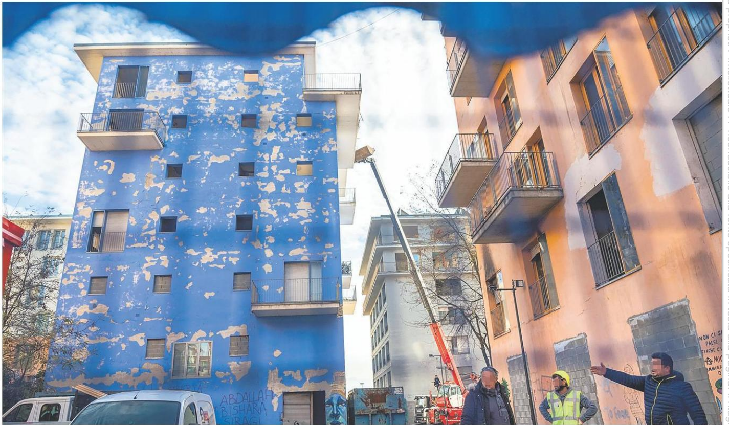
Il cantiere affacciato su via Giordano Bruno, in Borgo Filadelfia
